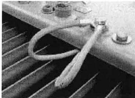
4. Уши за закрепване в четирите ъгъла на капака за закрепване на трансформатора по време на транспортиране и за приплъзване в помещението съгласно т.5.1 от ТС 16/03
