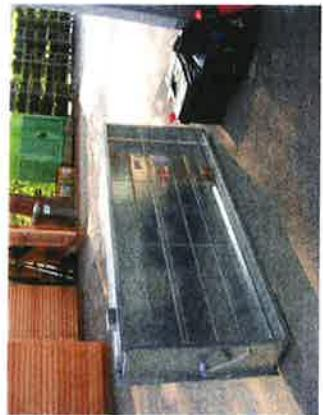
Пожарозащитният клапан с ламели съгл. Н 6031 в правоъгълна форма, с фланец за вграждане на задната стена на трафопоста заедно с горе споменатата вентиляционна решетка.
