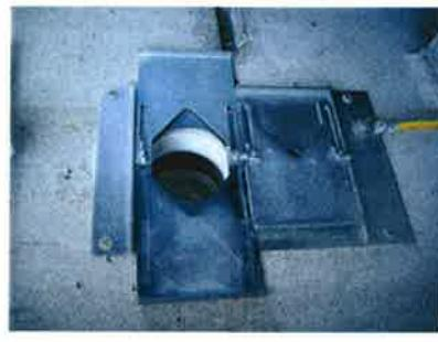
За захранването на БКП с аварийен агрегат в зоната на РУ ниско напрежение, се разполагат 2 броя затварящи се проходни изводи, които да не позволяват проникване с тел или други предмети до елементи под напрежение в трансформаторния пост и да могат лесно да бъдат отстранявани и отново монтиранi, на около 20 см над земята, с диаметър 100 mm) Достъпът до елемента позволяващ свързянето на капаците ( болт, гайка или др. ) да е от вътрешната страна на БКП.
