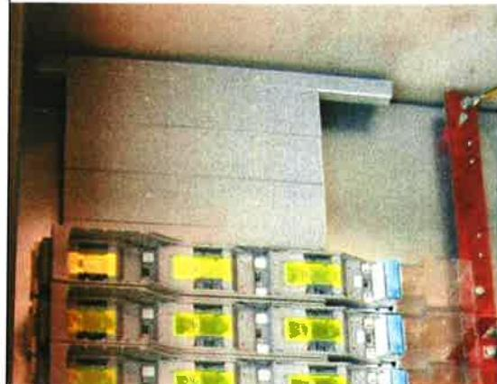
Трябва да бъде осигурена възможност допълнителното окомплектоване на разпределителното табло 0,4 kV с вертикални разединители с предпазители да става под напрежение.
