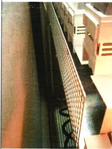
За вертикалните водещи надолу кабели изводи, трябва да бъдат монтирани носещи арматури, изпънати като С-профилни шини с размери 50x35 mm, които да могат да бъдат регулирани както вертикално, така и хоризонтално и да служат за закрепване на скобите. Да се обърне внимание на механичната устойчивост, като се имат предвид сляганиета в зоната на БКТП.
