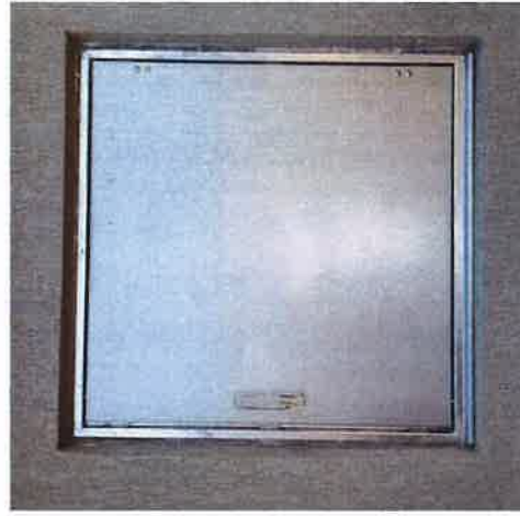
4.4.7 Тър for Messung auf MS-Ebene Aus komplett feuerverzinktem Stahl und Abmessungen 95 x 95 cm
