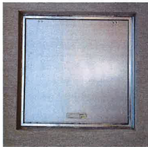
4.4.7. Врата за мерене средно напрежение Изработена изцяло от горещопоцинкована стомана и размери 95x95cm
